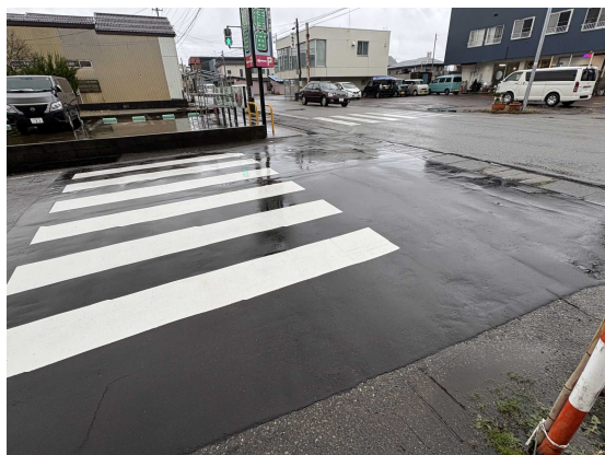
路面舗装、横断歩道の引き直し
